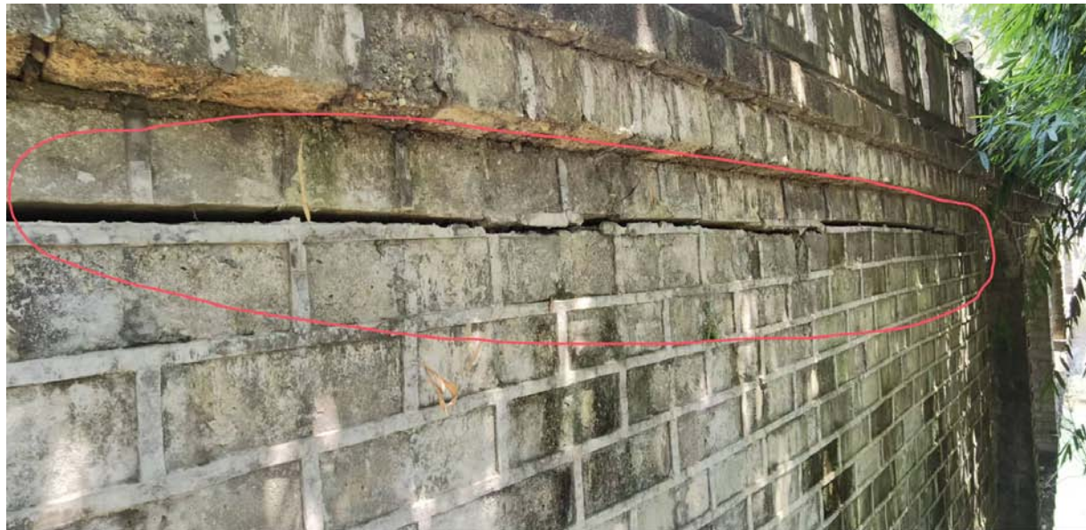
桥台侧墙上下分层通长裂缝
