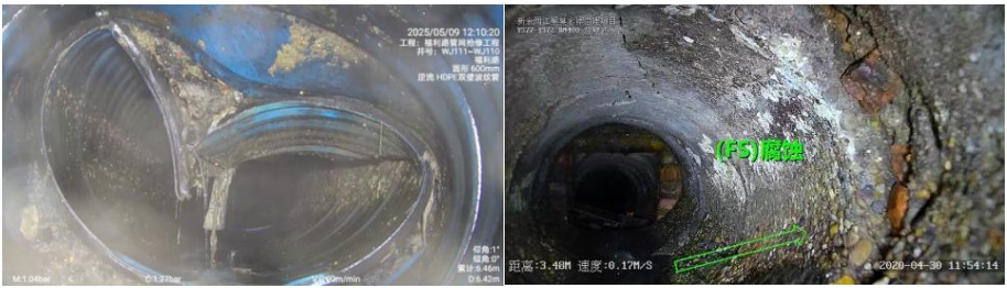
破裂 (PL) 腐蚀 (FS)
