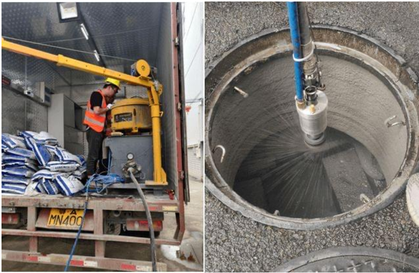
检查井砼盾喷涂示意图（2）
