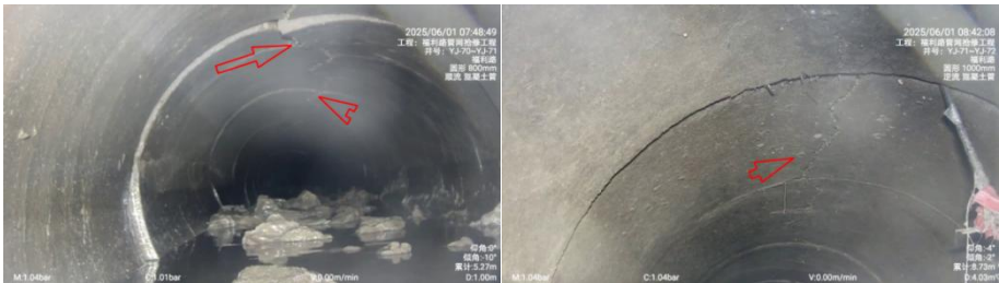
有较长的纵向裂缝，不影响使用但存在较大隐患
