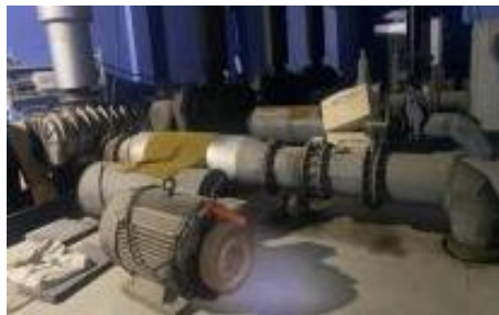
图：现状罗茨风机已处于长期停机状态
