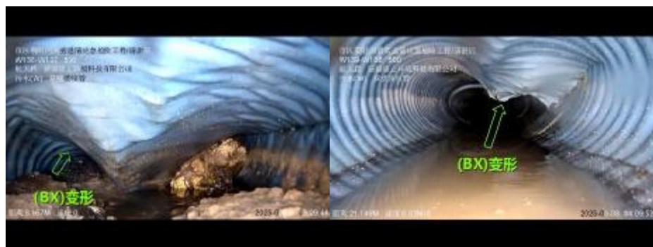
航天路污水管道缺陷影像
