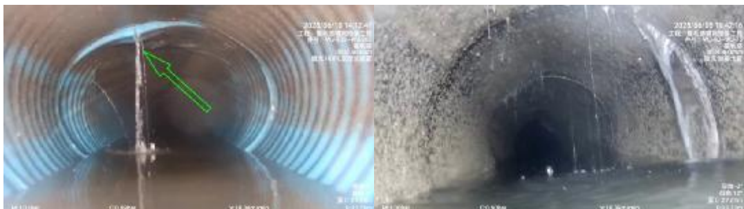
渗漏严重, 导致过多地下水进入污水厂
