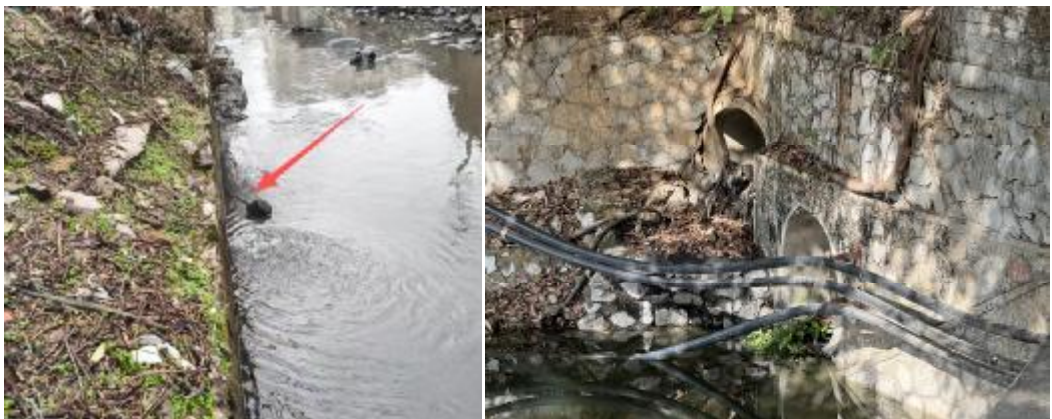
左：东二环污水通过裂隙溢流至朝阳河支渠
