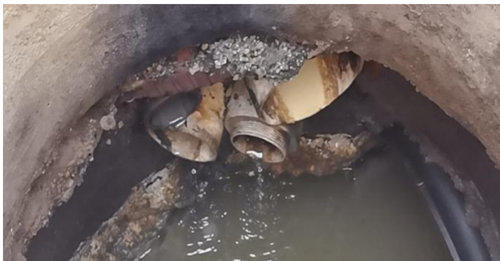
污水错接进入雨水管网
