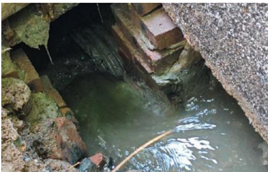
鲁山水泥厂污水接入雨水井
