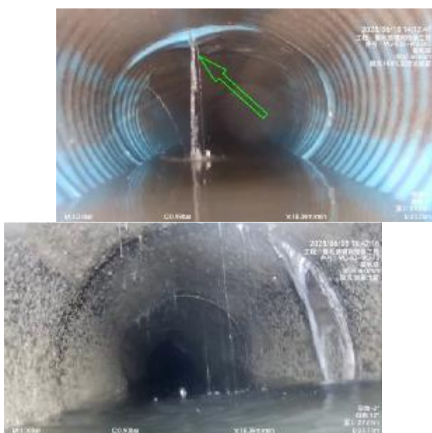
渗漏严重, 导致过多地下水进入污水厂
