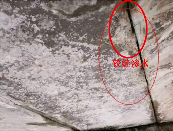
1-4#空心板板底横向裂缝、铰缝渗水
