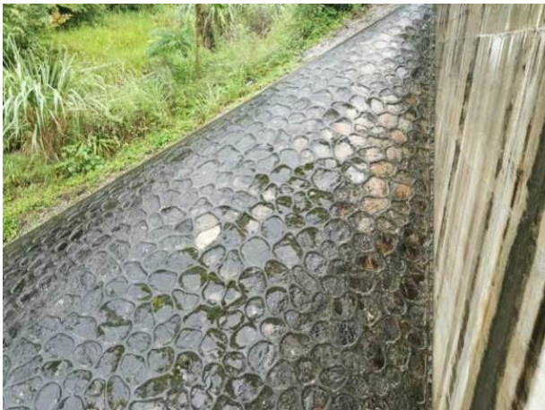
1#左侧锥坡现状
