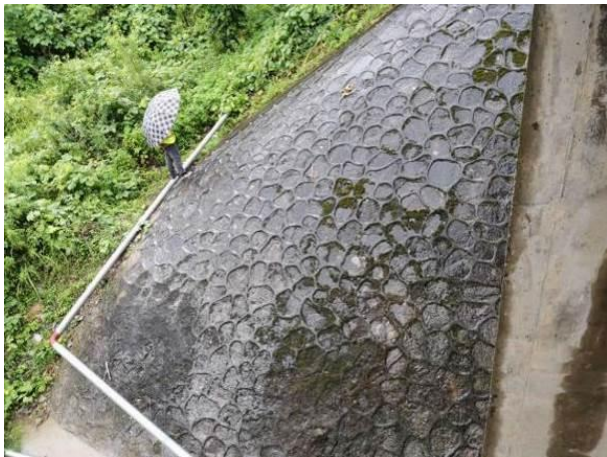
0#右侧锥坡现状
