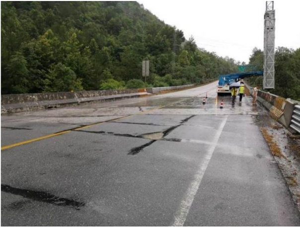
回河小桥桥面照
