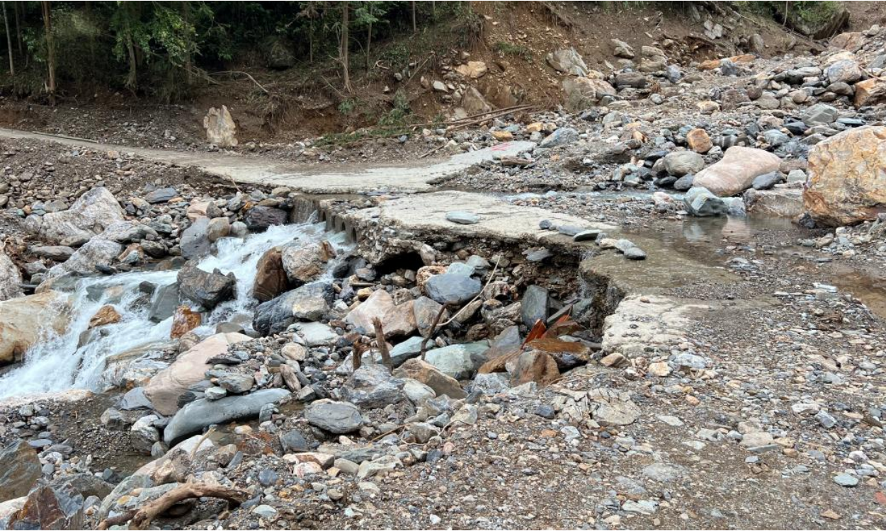
桥位现状照片
