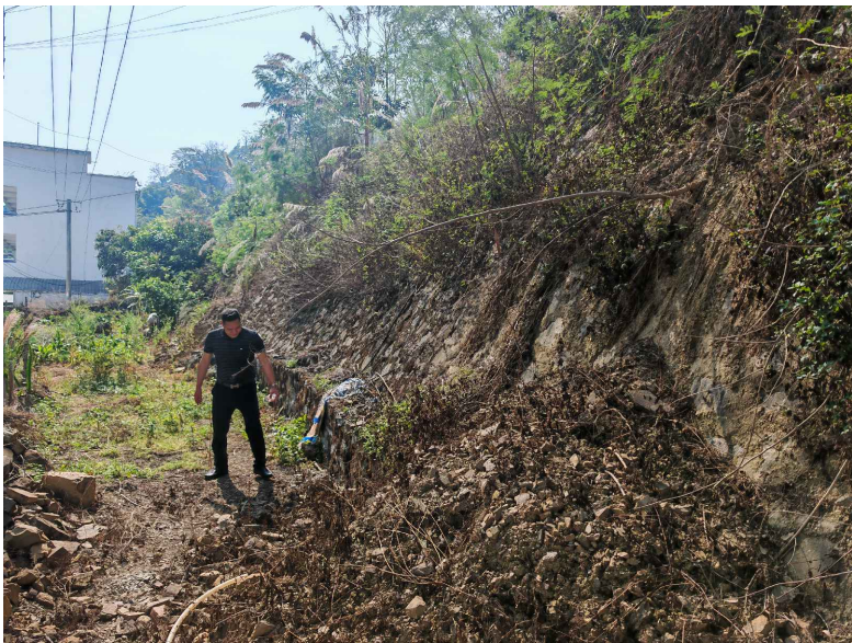
原2#挡土墙现状图
