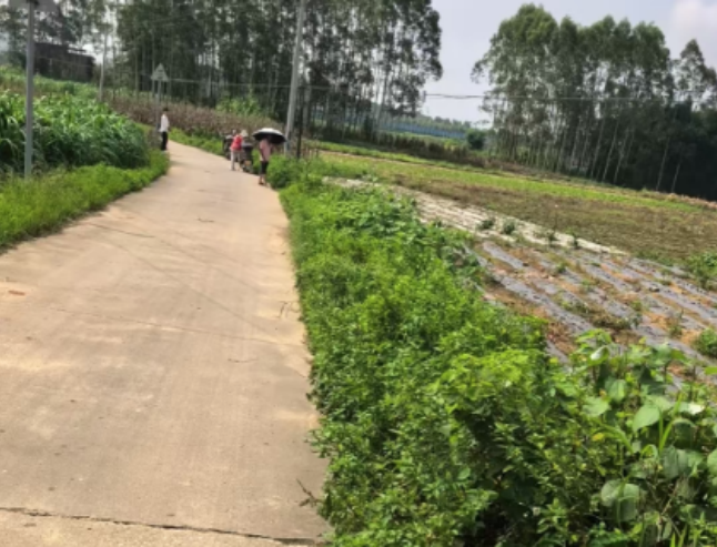
现状道路过窄，需加宽
