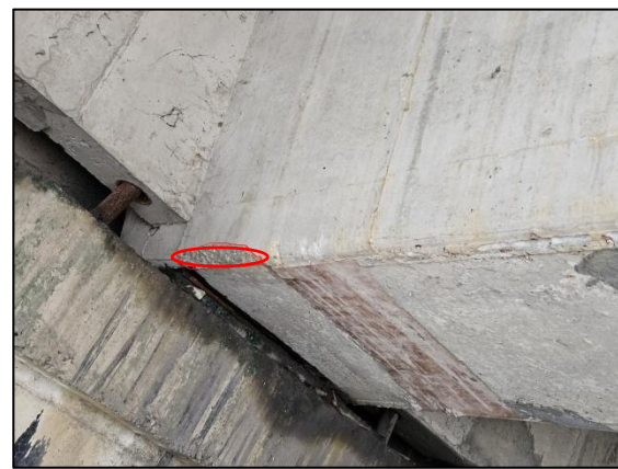
混凝土剥落
