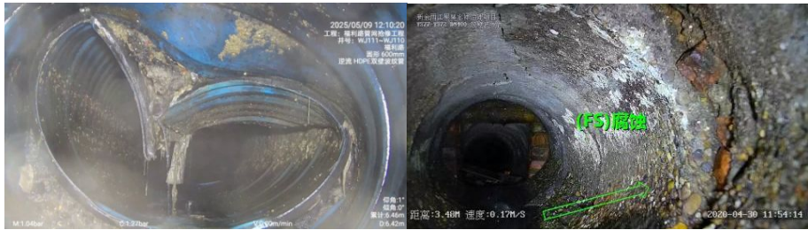
破裂 (PL) 腐蚀 (FS)
