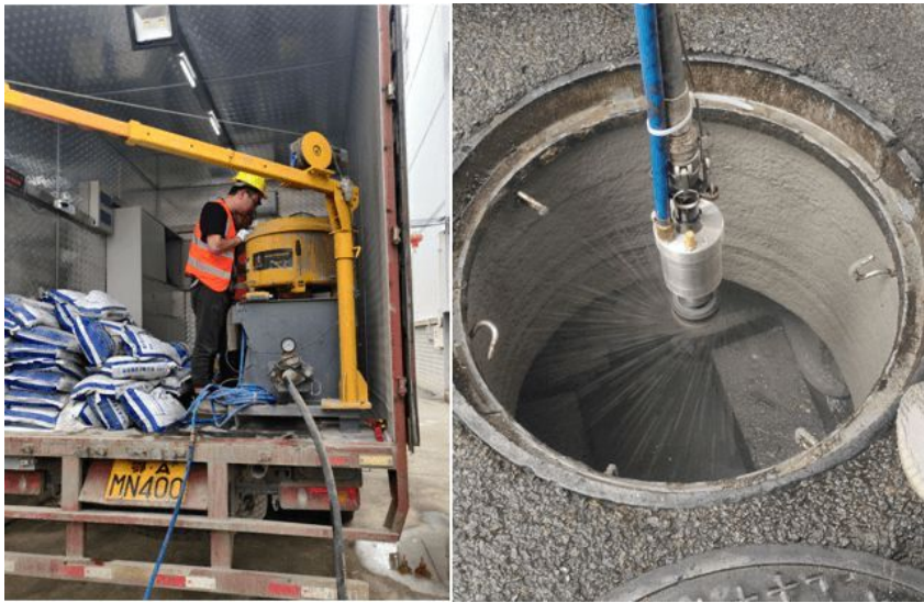
检查井砼盾喷涂示意图（2）
