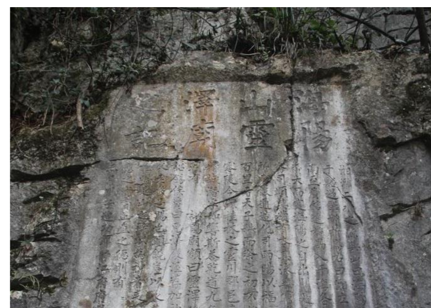
图 6.1-3 石刻表面裂隙病害
