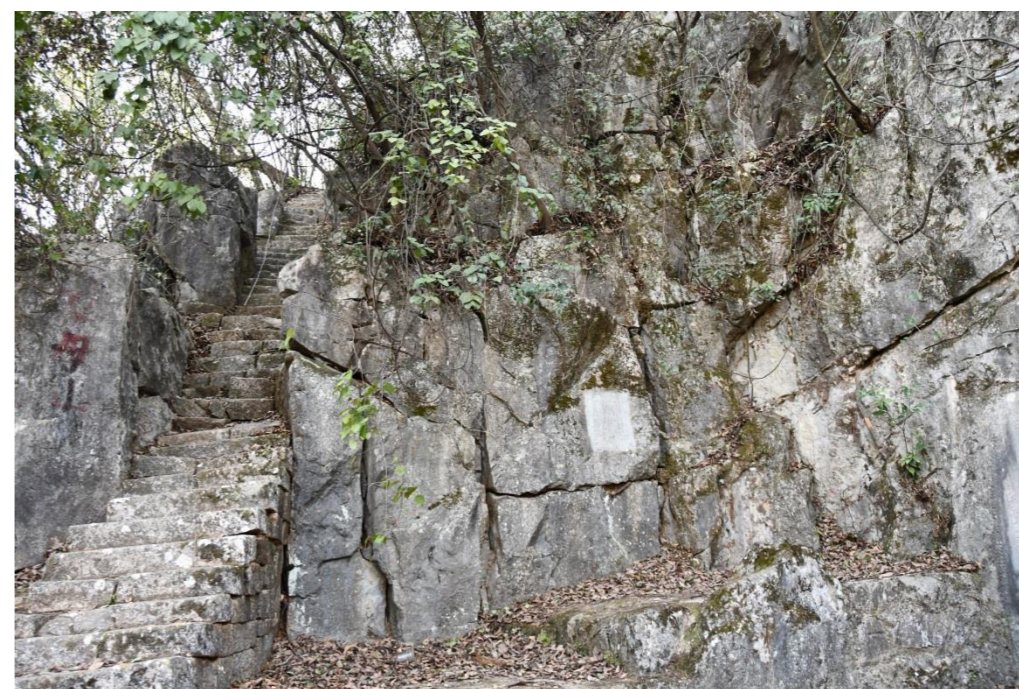
图 4.2-3 崖壁发育构造裂隙
