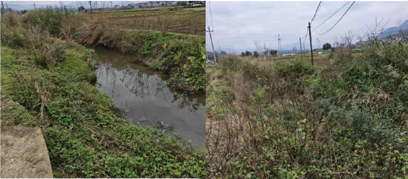
水渠现状照片
