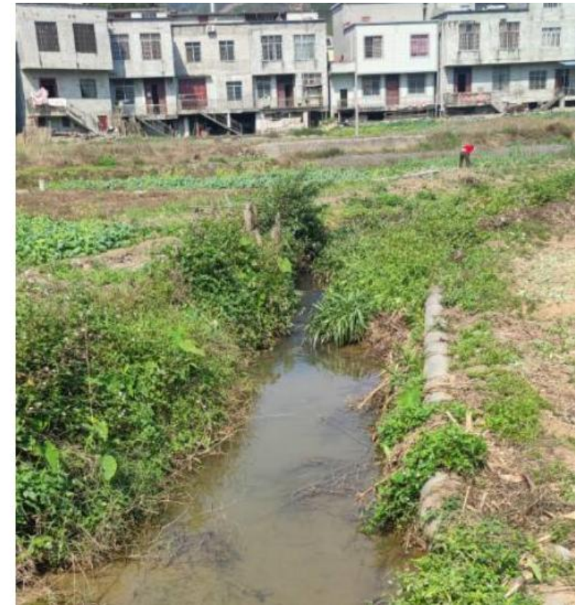
现场照片：河道堵塞，河堤塌方
